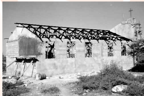
Juni 2004: Die Kirche ist gewachsen, das Wellblechdach wird bald aufgesetzt.
